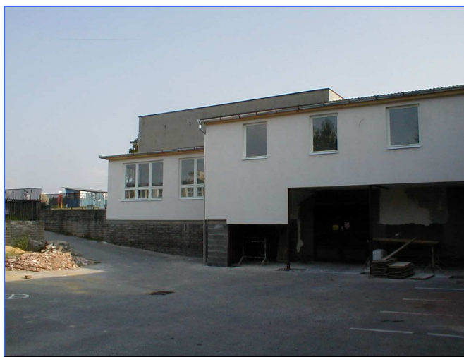
Spojovací chodba je nejnáročnější prvek rekonstrukce
